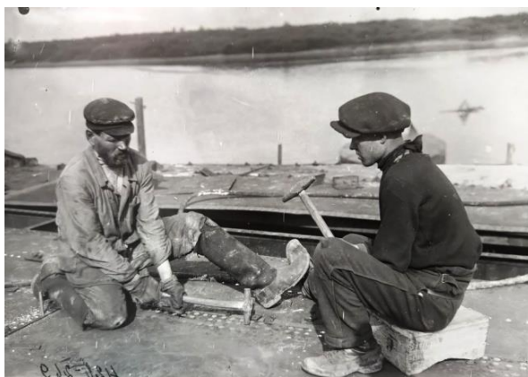
Завод «Красное Сормово» чеканка заклепок ручным способом, 1930 г.
